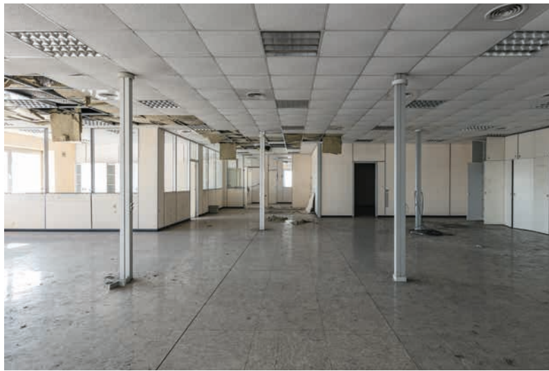
Les halls d'usine et les bureaux vides de Renault Vilvoorde, 20 ans après sa fermeture.
